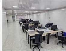
ADECUACIONES ELECTRICAS Y DATOS
